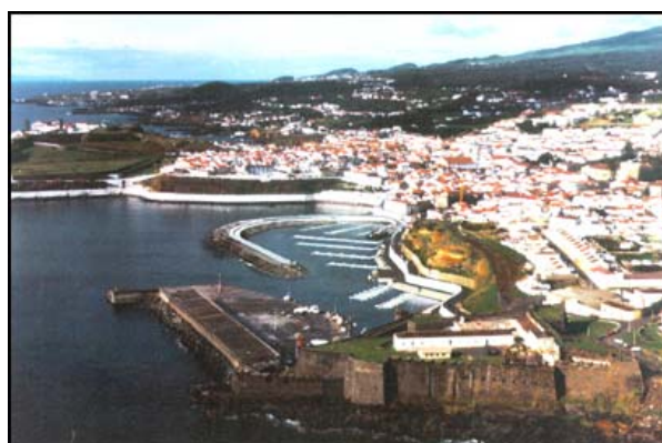
Código do Projecto: 47-01-02-00036 Construção do Porto de Recreio de Angra do Heroísmo Terceira
