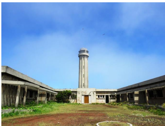
Figura 6 - Aspeto geral das infraestruturas do complexo do farol e da torre da lanterna.
