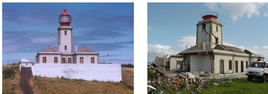
Figura 2 - Farol antes e depois do sismo de 1998
