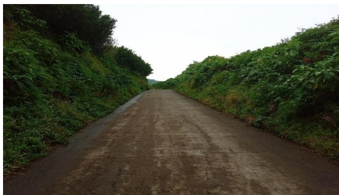
Caminho da Água Nova (Relva) limpeza realizada no presente mês de agosto.
