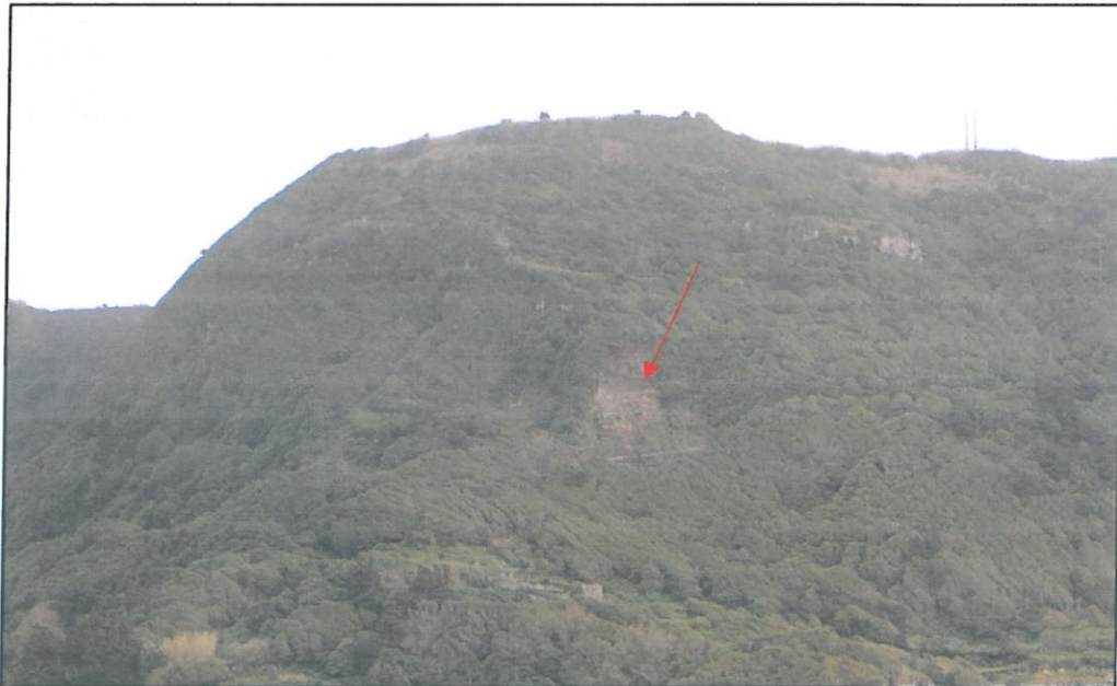
Figura 2- Enquadramento geral do local onde ocorreu a instabilidade.
