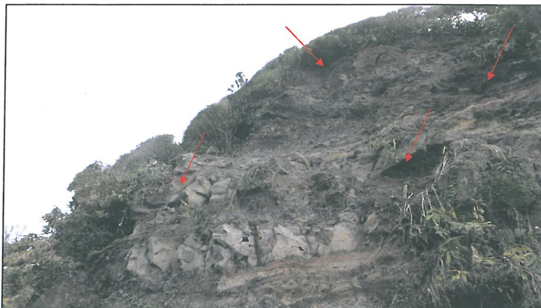
Figura 6- Blocos e/ou cunhas de solos em situação de instabilidade na superfície da cicatriz.
