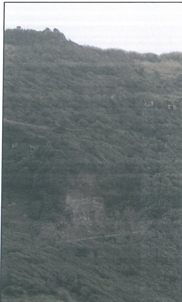
Figura 4- Vista geral do talude onde ocorreu a instabilidade.
