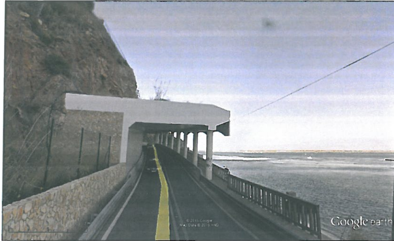
Figura 12 – Exemplos de estruturas em semi-túnel aplicado a taludes com potencial para a ocorrência de processos de instabilidade geomorfológica (em Santa Cruz - Tenerife e na Serra da Arrábida – Portugal).
