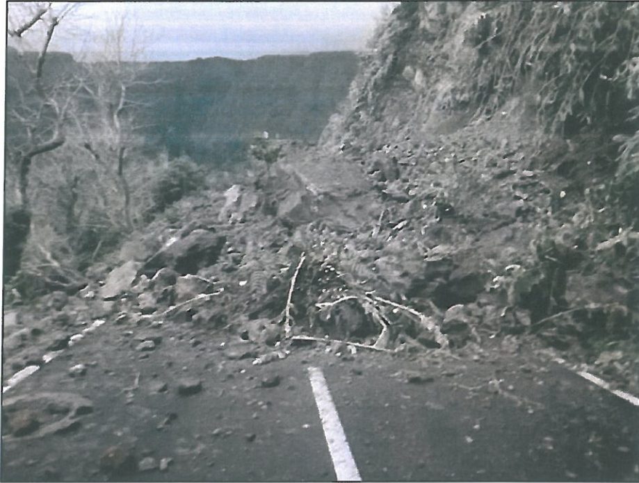
Figura 5- Depósito do material resultante do deslizamento.
