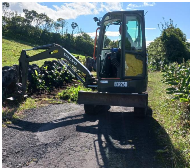
Processo de limpeza de bermas. Novo equipamento adquirido
