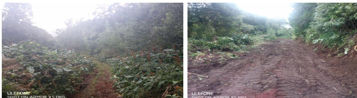
Fotos do Antes e o Depois dos trabalhos de limpeza
