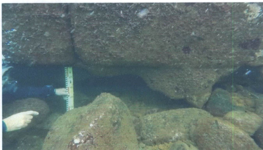
Fig.17 – Loca na fundação dos blocos do primeiro troço
