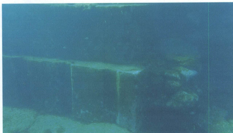
Fig. 8 – Fundação das duas primeiras colunas de 3 aduelas da Cabeça
