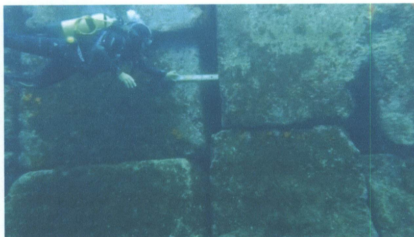
Fig.23 – Junta vertical com cerca de 20cm e blocos com arestas e cantos partidos
