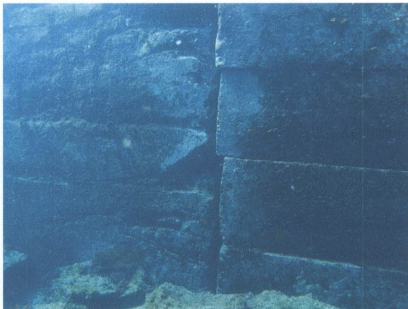
Fig.29 – Face Nascente da infraestrutura do Muro de remate
