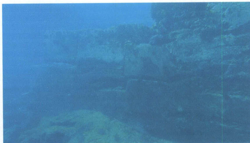
Fig. 14 – Muro de Remate do Prisma de Enrocamento
