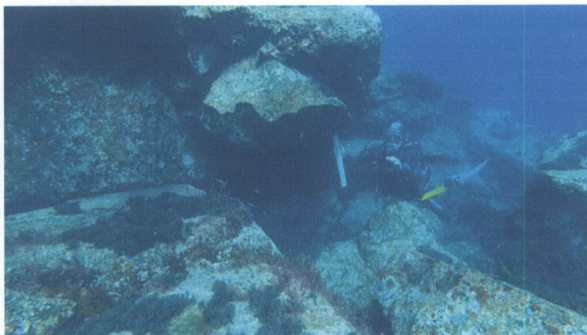
Fig.31 – Extremidade do Muro de Remate virada a Sudeste em consola
