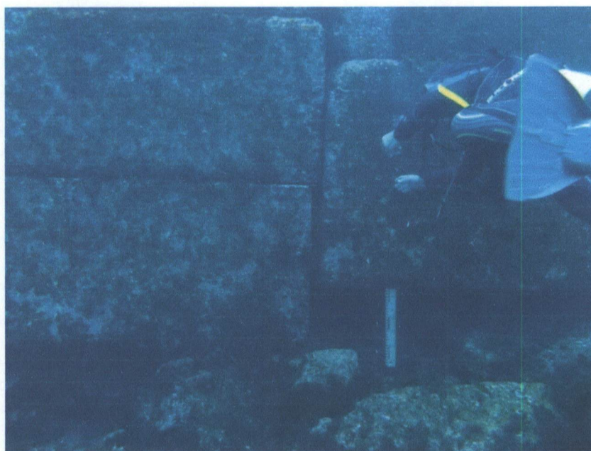
Fig.19 – Loca na fundação da última coluna de blocos antes das aduelas
