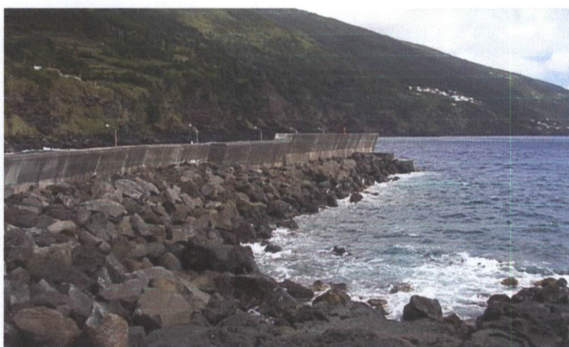
Fig. 2 - Vista geral do lado exterior do molhe-cais
