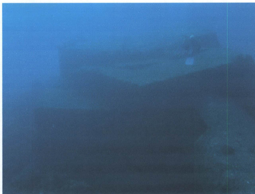
Fig.24 – Parte da Extremidade do Molhe – Cais derrubada no temporal de Janeiro de 1987
