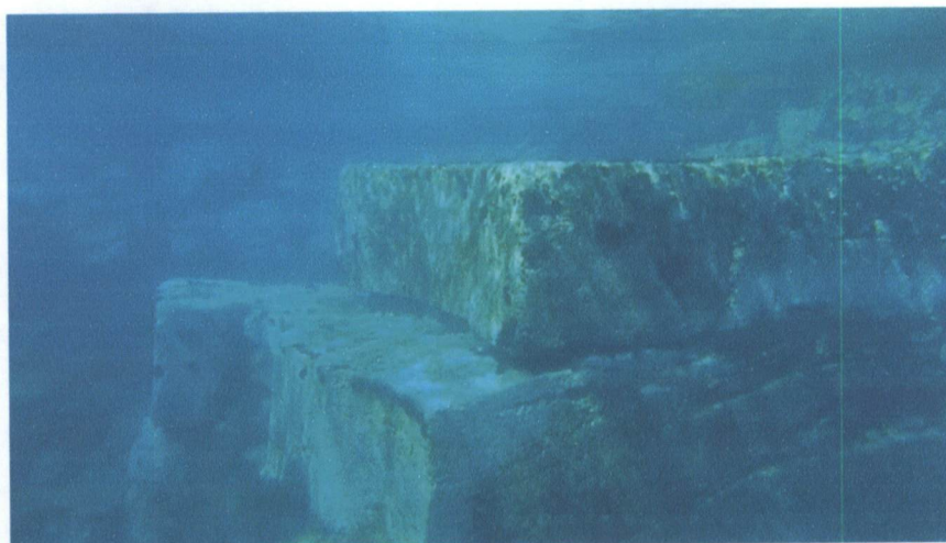
Fig. 13 – Muro de Remate do Prisma de Enrocamento
