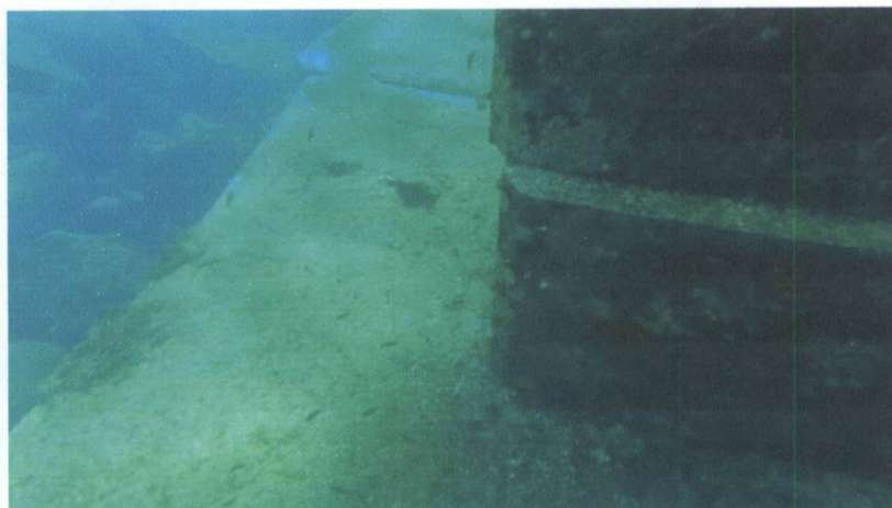
Fig. 6 – Fundação das duas primeiras colunas de 3 aduelas da Cabeça
