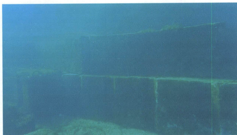
Fig. 9 – Fundação das duas primeiras colunas de 3 aduelas da Cabeça
