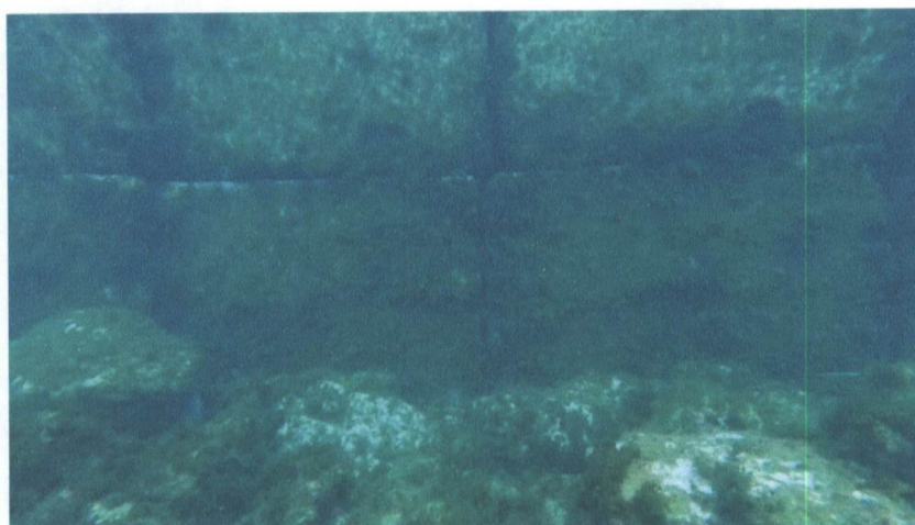
Fig.21 – Apoio de blocos desencontrados a partir da vigésima quarta coluna
