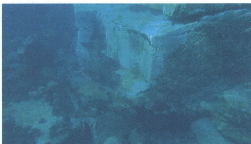
Fig.30 – Extremidade do Muro de Remate virada a Sudeste em consola
