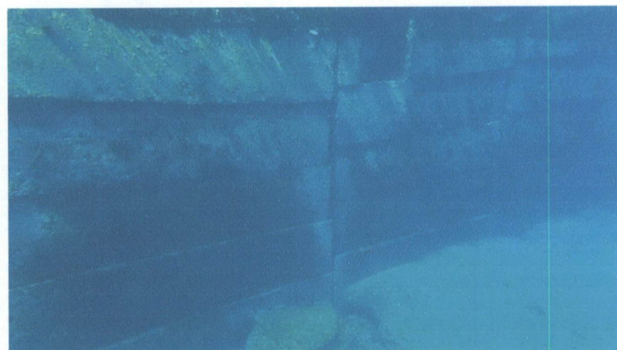
Fig. 12 – Fundação das três colunas de 5 aduelas da Cabeça
