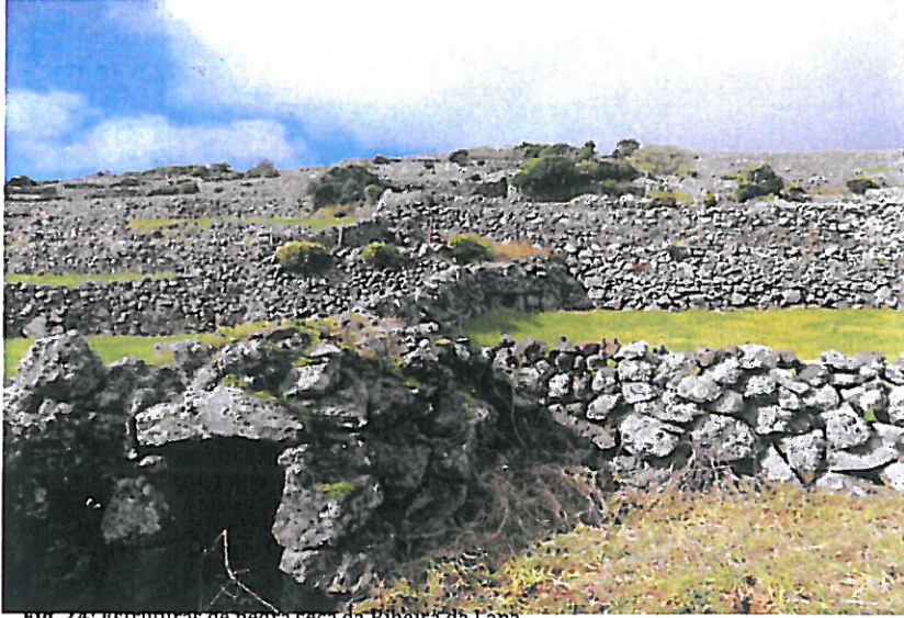
Fig. 24: Estruturas de pedra seca da Ribeira da Lapa
