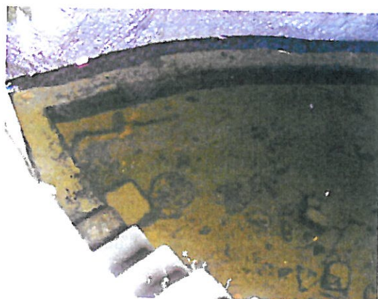
Fig. 18: Monte Brasil. Cisterna escavada na rocha, com escadaria de acesso e vestígios de reboco.
