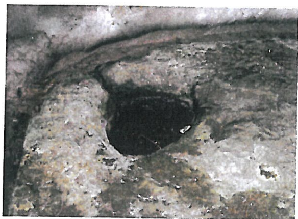
Fig. 17: Monte Brasil. Pias e canaletas, talhadas na rocha em cavidade artificial escavada a picão para recolha de águas
