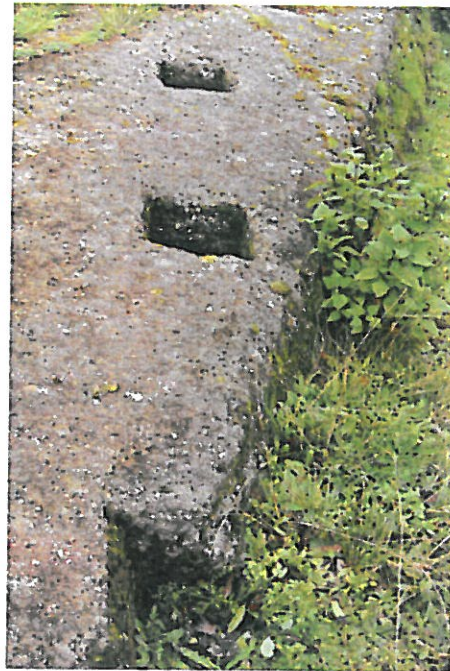
Fig. 14: : Pico do Facho, Monte Brasil. Estruturas escavadas na rocha, para instalações de madeira de apoio ao posto de sinalização
