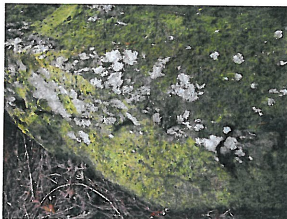
Fig. 12: Incisões feitas a guilho, que correspondem ao processo de corte de pedra
