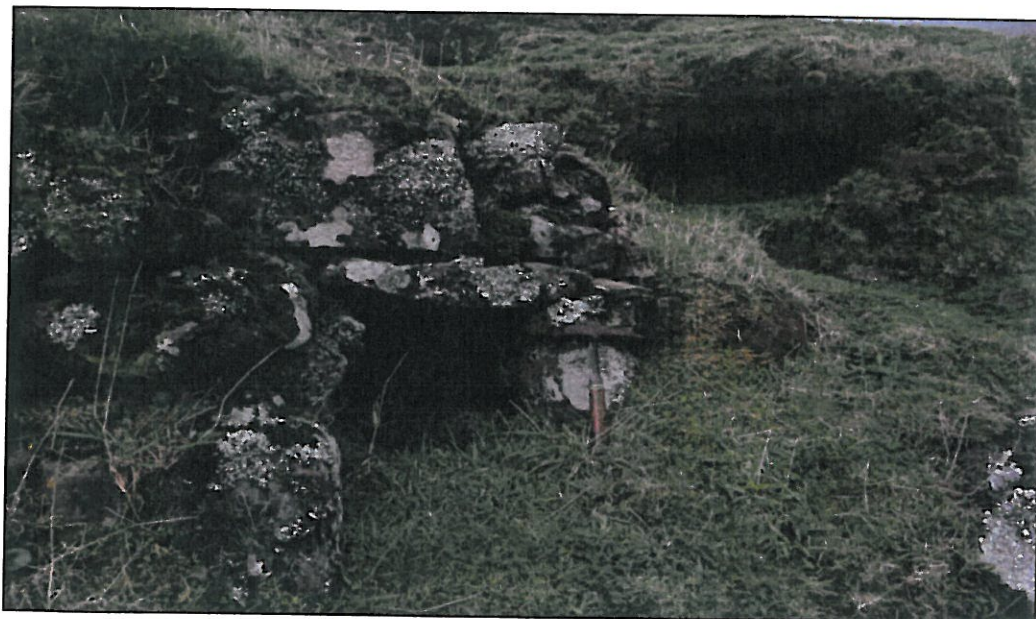
Fig. 21: Estruturas de pedra seca em Ribeira das Árvores
