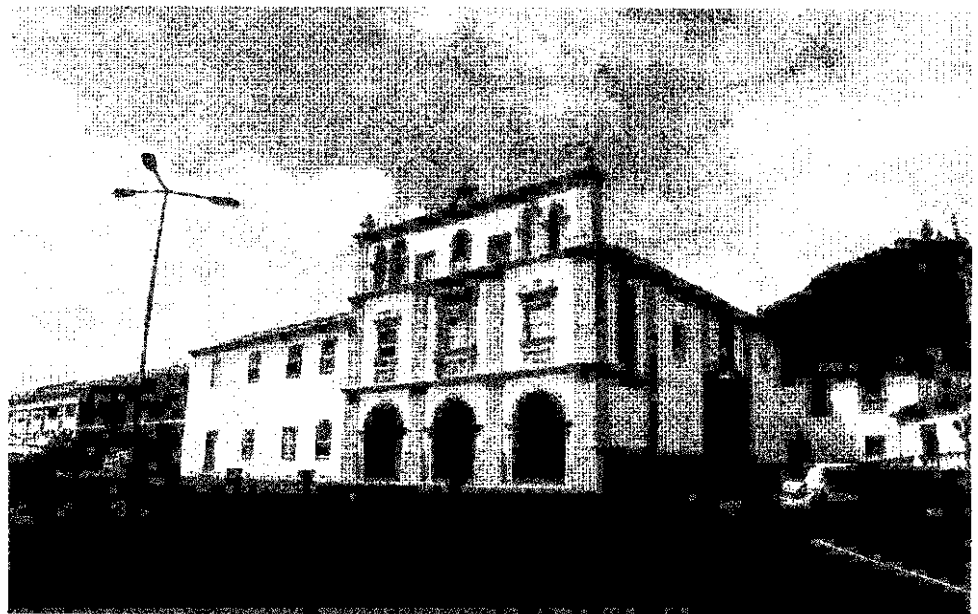
Convento de S. Boaventura depois da pintura das cantarias e recuperação das fachadas
