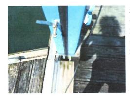
A rede de abastecimento de água necessita intervenção e substituição, mantendo constantes perdas de água, contribuindo para a danificação das madeiras dos passadiços, sendo os passadiços que se encontram nas zonas em torno destes pontos as que se encontram em pior estado de conservação.
