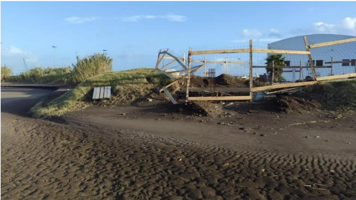
**Imagem 3** - Captada a 23 de dezembro de 2021 onde são visíveis os danos na vedação da obra provocados pelo galgamento do mar para além da zona da duna, atingindo a implantação da obra, bem como o corte efectuado na duna na sua zona a montante (Praia da Riviera – Cabo da Praia)
